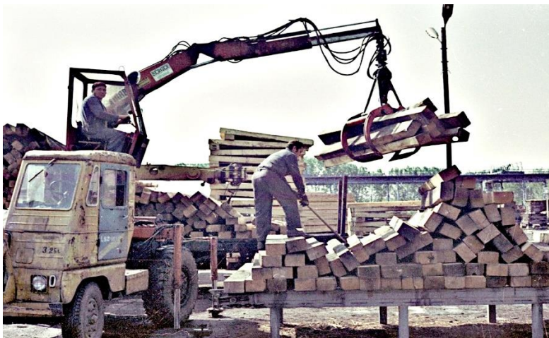
Talpfa rakódása a pántoló gépnél Hiab-Berger rakódógéppel. A gépkezelő Papp Lajos, a rakódó Nagy József.
