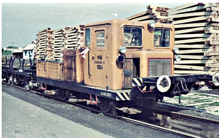
A „Mukit” leváltó TVG zsámolykocsikon levő kengyelkocsikat továbbít a fatéren.
