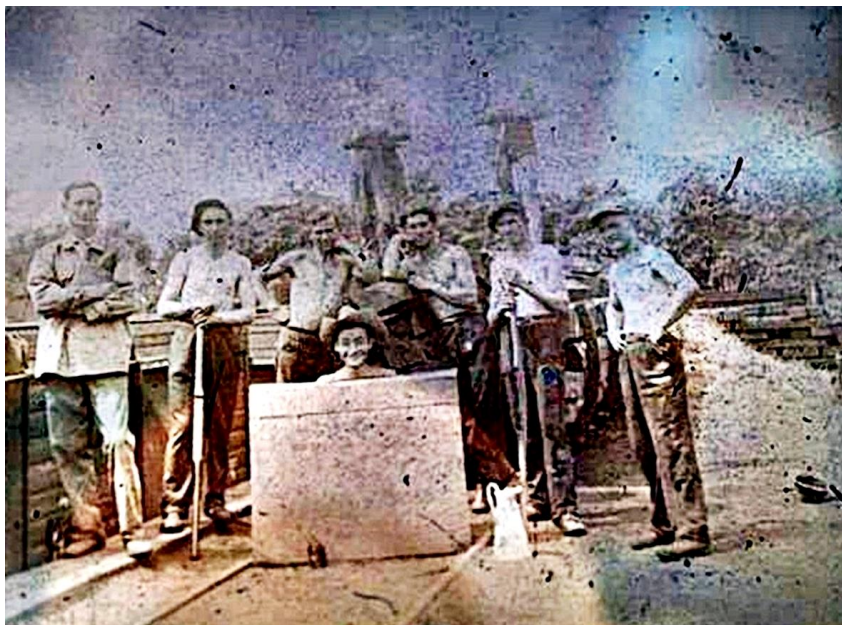
Telített talpfa vasúti kocsiba való berakását végző brigád a ponkon. Kettő munkás kezében a rakódást segítő „csapófa”. (Forrás: DRSzN fb. csoport)
