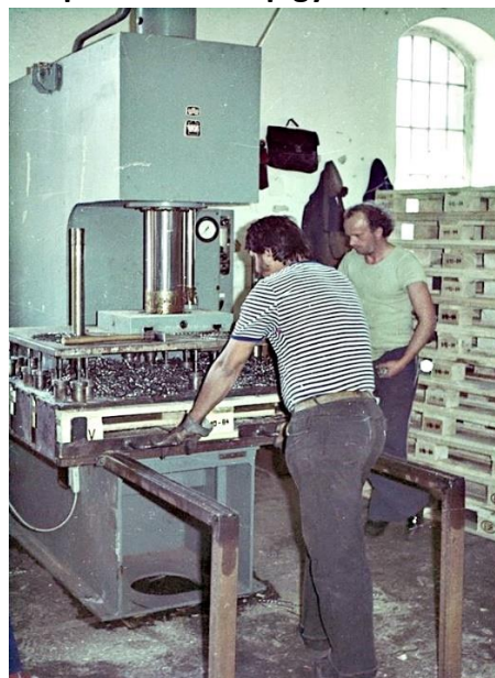
Rakódólap készítése a présgépre készített szegező szerszám első változatával.
