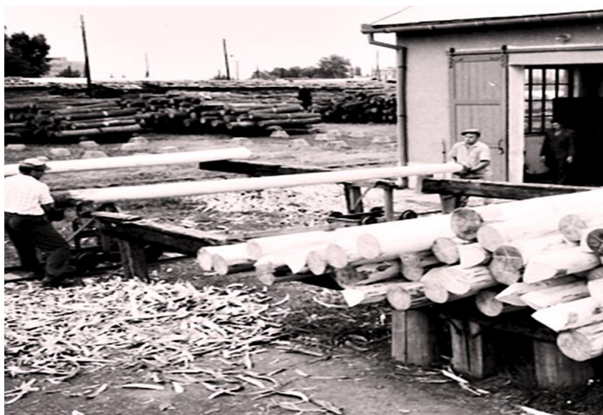
A háncsológép üzembehelyezése után csak az oszlop két végét kellett kézzel háncsolni. (Forrás: DRSzN fb. csoport)
