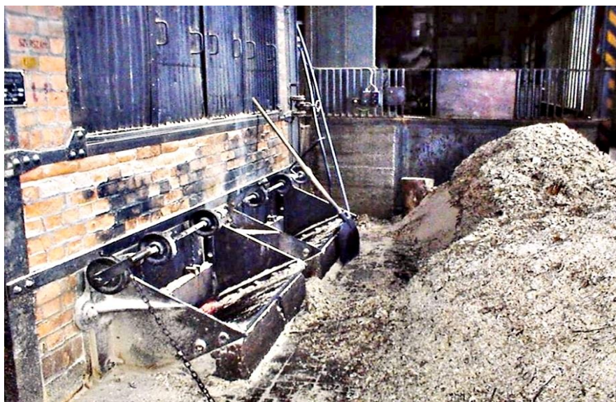
A Steinmüller gőzkazán tűztér ajtajai, előttük az eltüzelésre váró fűrészpor. (Forrás: DRSzN fb. csoport)
