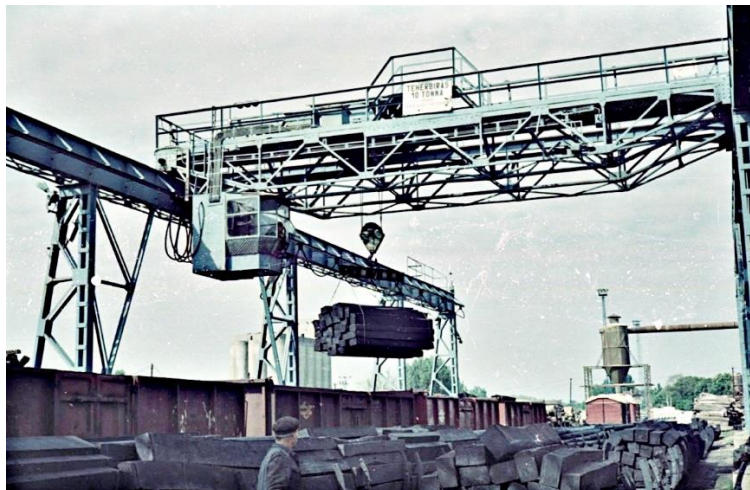
A futódaruval telített talpfát rakódnak vasúti kocsiba.
