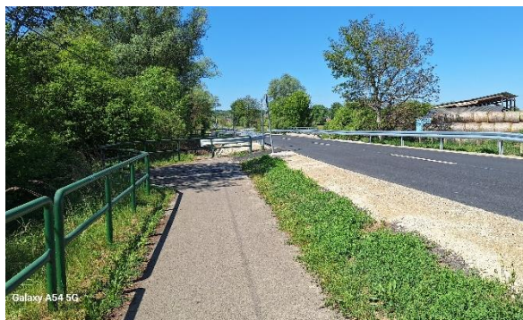
Szőlőhegyi út, 0+290 km. sz. híd
